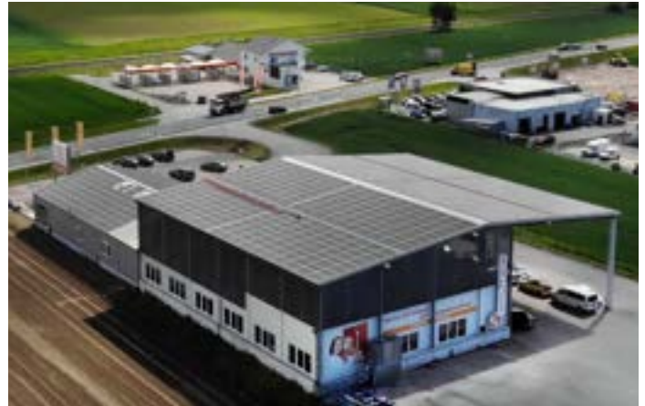
easyTherm® Kompetenzzentrum in Unterwart: 300kWp PV-Anlage für CO 2 -neutrale Produktion
