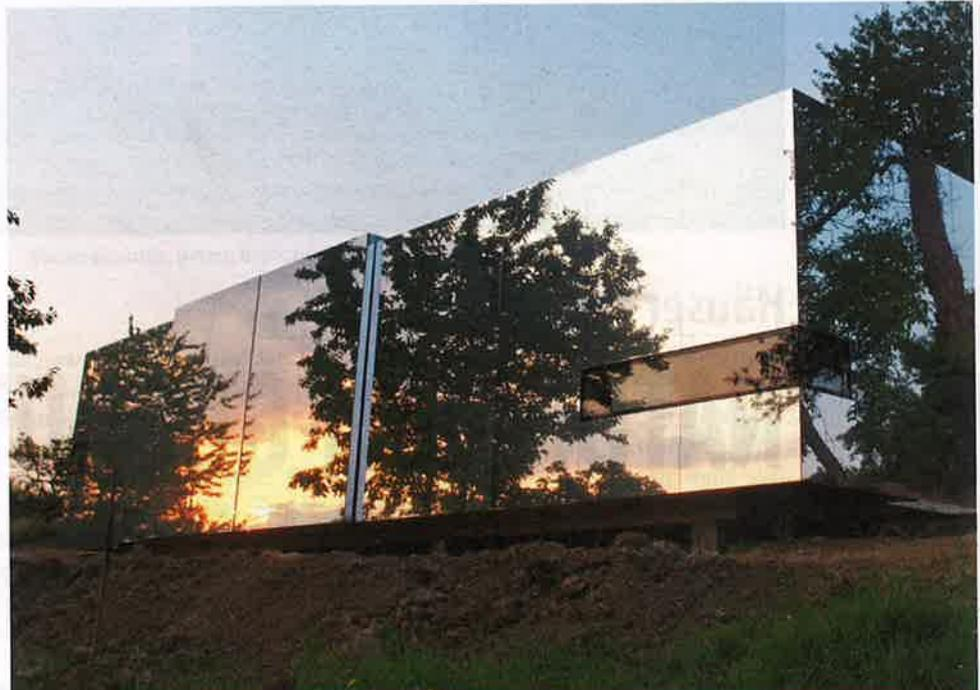
**Spiegelhaus.** Die Wiener Architekten von Delugan Meissl Associated Architects realisierten auf einer Grundfläche von 45 m<sup>2</sup> einen Container-Bungalow. Die Außenfassade aus Aluminium nimmt das Muster der Umgebung fast unverzerrt auf und ist damit nahezu unsichtbar. [www.dmaa.at](http://www.dmaa.at)
