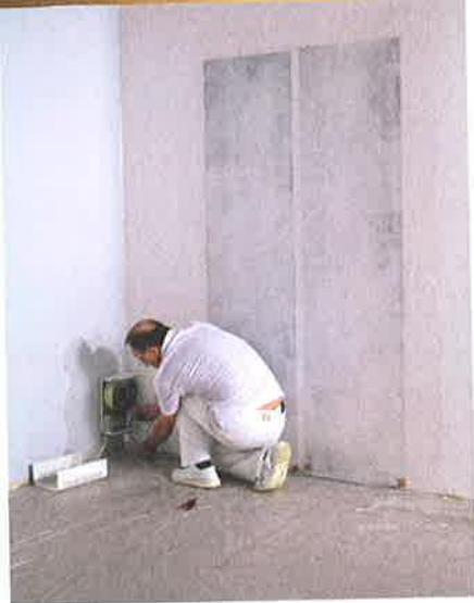
Beim „Comfort-Heating“ werden dünne Heizfolien unter dem Putz oder der Tapete verlegt, die Strahlungswärme erzeugen. Foto: epr/M-Therm
