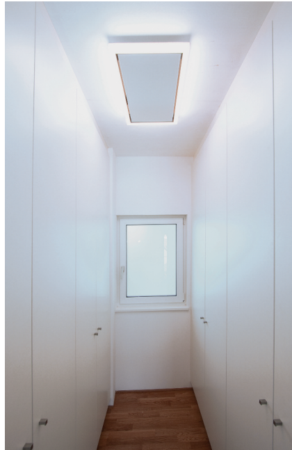
Die Heizleistung ist auf jede Wohnungsgröße abgestimmt – die 85 m 2 -Wohnung benötigt gerade einmal 2.000 Watt Heizleistung.
